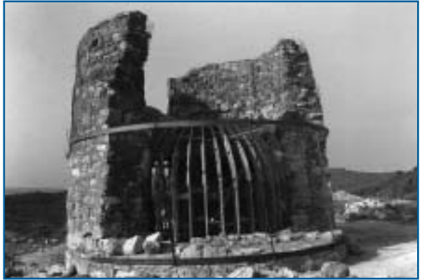
Ruines du moulin de Balayé à Nissan avant sa restauration
