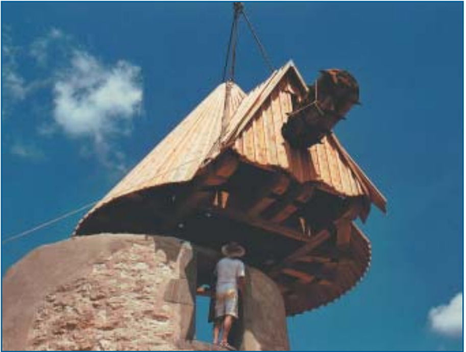
Pose avec une grue de la capelade du moulin de Villeneuve Minervois
