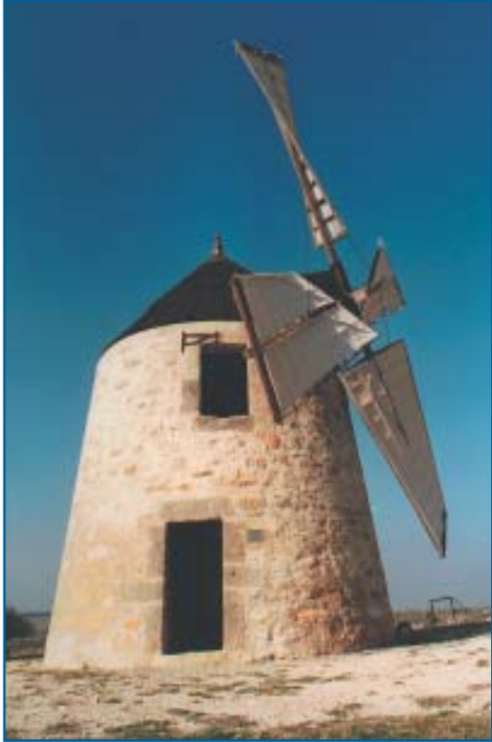
Ailes du Moulin Balayé, à Nissan: courbure des ailes
