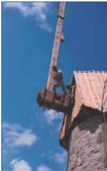
Mise en place d'un bras d'aile de moulin
