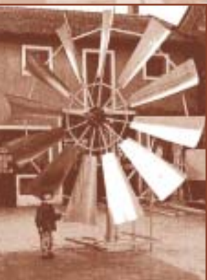
Roue d'éolienne SENIOREOL 310 (diamètre 3,10 m) (Évaluez les dimensions par rapport à Nicolas Humblot, 3ans).
