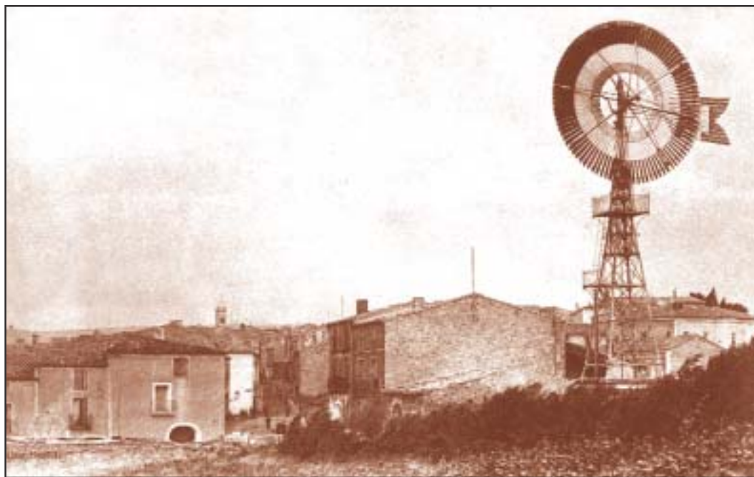
Une éolienne multipale "Eclipse" de Plissonnier, en service à Villeveyrac (Hérault) au début du XX e siècle. Collection Francis Delbée.
